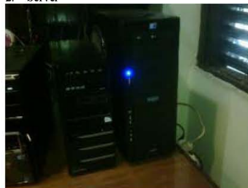
Gambar 13. Server yang digunakan untuk sistem PDE
