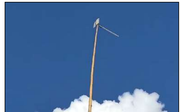
Gambar 8. Pemasangan Antena Yagi
