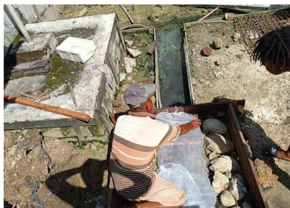
Gambar 1. Proses pembuatan landasan tandon
